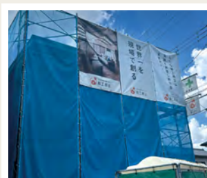
視察② 着工中現場
