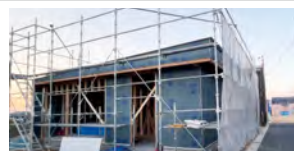
視察③ 建築現場
